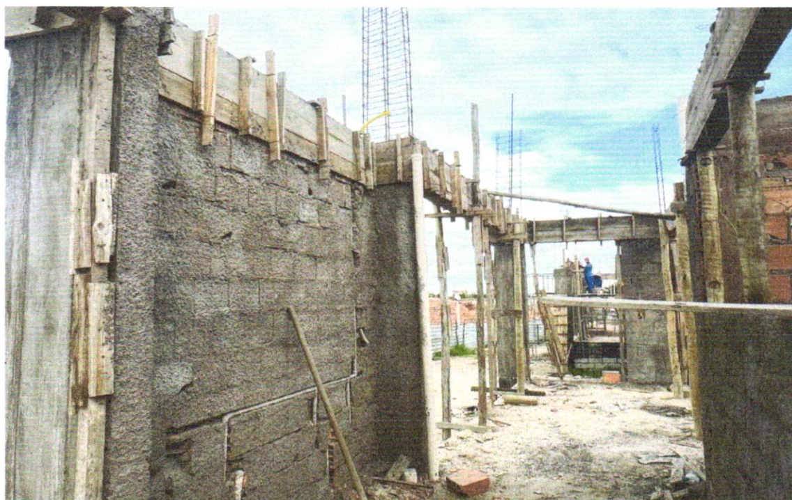
FOTO 20 – Chapisco de aderência em paredes internas, externas, vigas, platibanda e calhas
