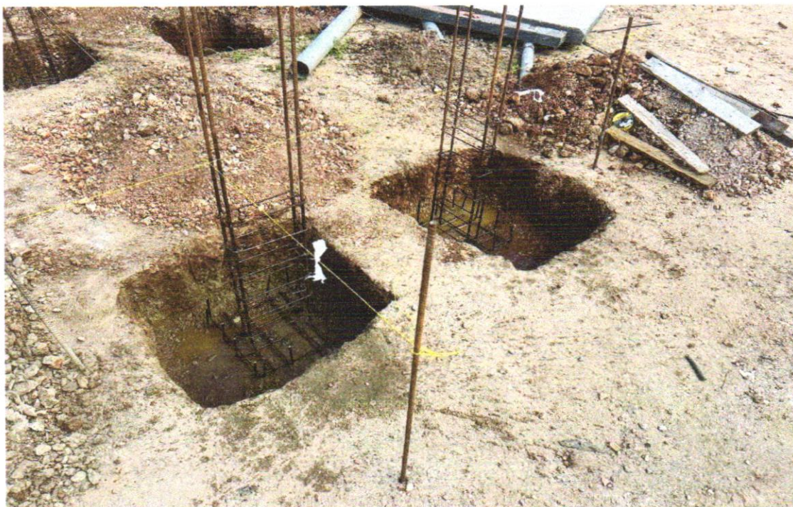
FOTO 08 – Regularização e compactação do fundo de valas
