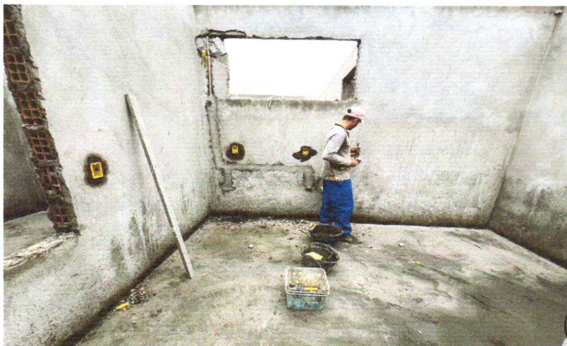
FOTO 36 – Caixa de passagem PVC 4x2"
