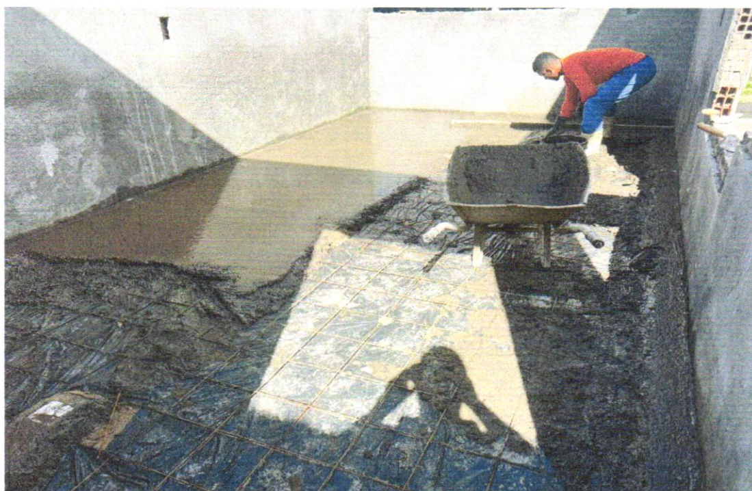
FOTO 40 – Camada regularizadora traço 1:4 (cimento e areia) espessura 2cm
