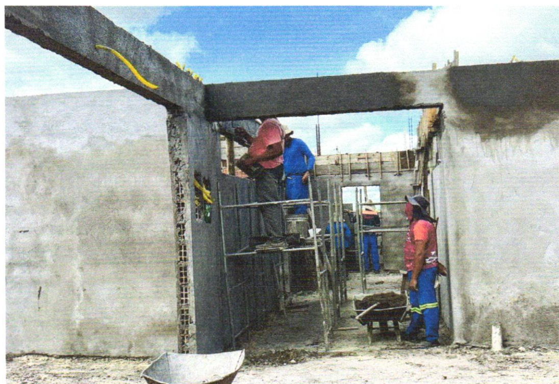
FOTO 24 – Emboço paulista para paredes externas traço 1:2:9 - preparo manual - espessura 2,5 cm
