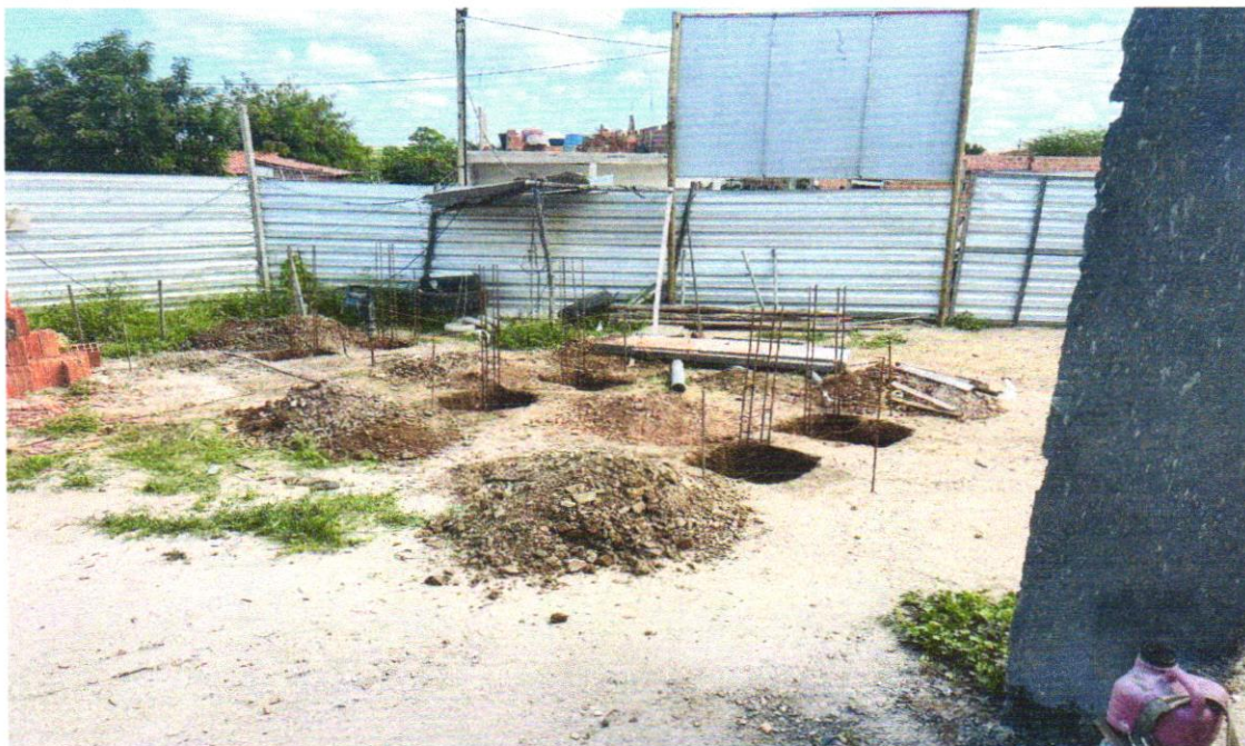
FOTO 08 – Regularização e compactação do fundo de valas
