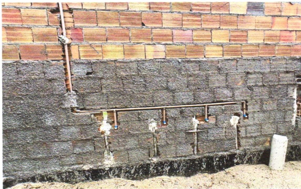
FOTO 28 – ADAPTADOR CURTO COM BOLSA E ROSCA PARA REGISTRO, PVC, SOLDÁVEL, DN 25MM X 3/4", INSTALADO EM PRUMADA DE ÁGUA - FORNECIMENTO E INSTALAÇÃO. AF_12/2014
