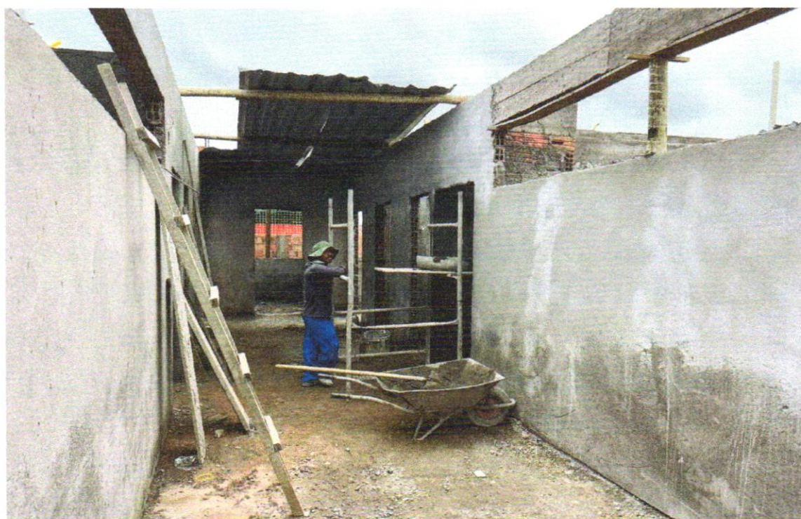
FOTO 26 – Reboco para paredes internas, externas, pórticos, vigas, traço 1:4,5 - espessura 0,5 cm
