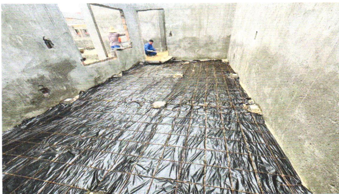
FOTO 38 – Contrapiso de concreto não-estrutural, espessura 3cm e preparo mecânico
