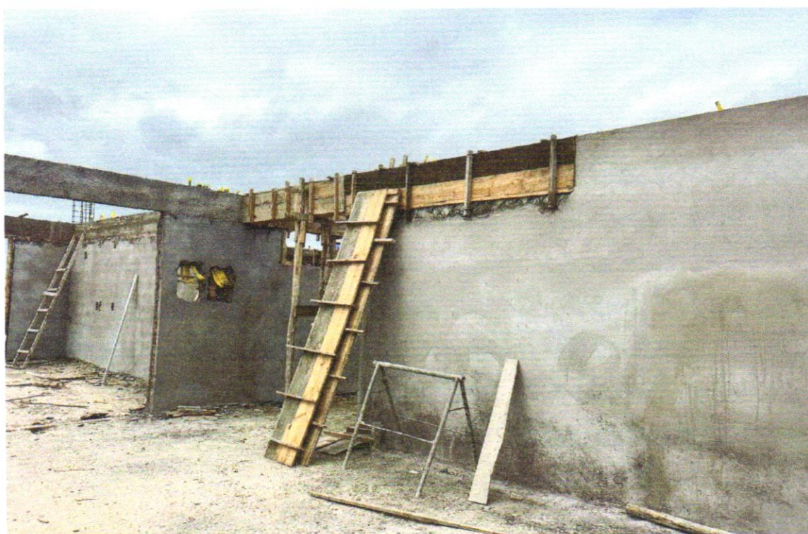
FOTO 06 - Concreto Bombeado fck= 25MPa; incluindo preparo, lançamento e adensamento
