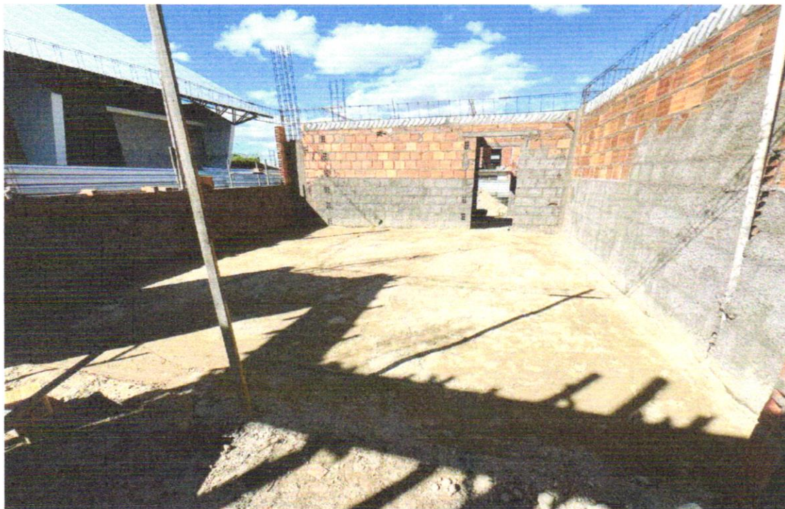
FOTO 20 – Chapisco de aderência em paredes internas, externas, vigas, platibanda e calhas
