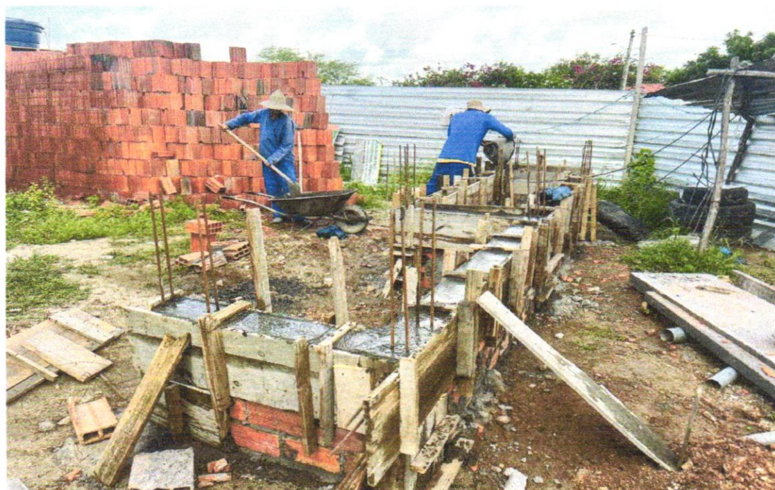
FOTO 14 – Armação de aço CA-50 Ø 8mm; incluso fornecimento, corte, dobra e colocação
