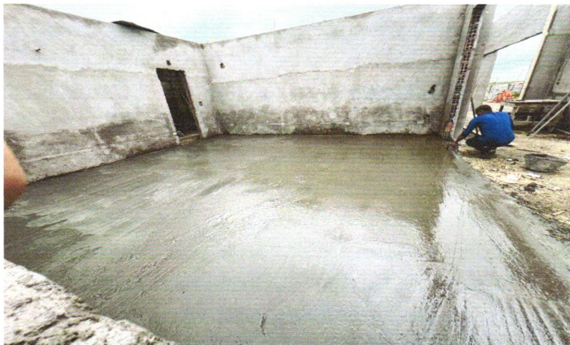
FOTO 41 – Camada regularizadora traço 1:4 (cimento e areia) espessura 2cm
